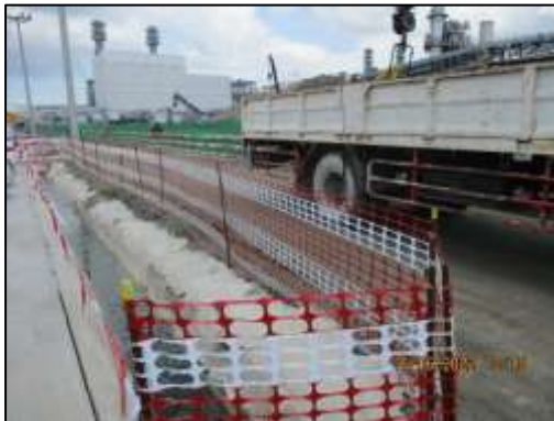
รูปที่ 2-14 รางระบายและรางรวบรวมน้ำฝนชั่วคราว
