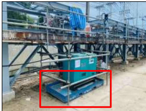
รูปที่ 2-8 ภาพขณะรองรับน้ำมันหล่อลื่น
